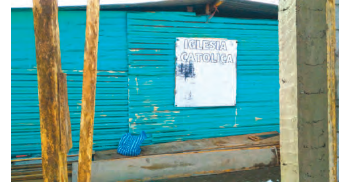
Dokumentation des Kirchenbaus.
